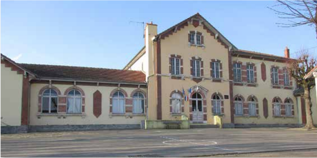
École élémentaire Anatole France, Bois-du-Verne, ancienne école de la Mine, 1870, architecte Goichot.
