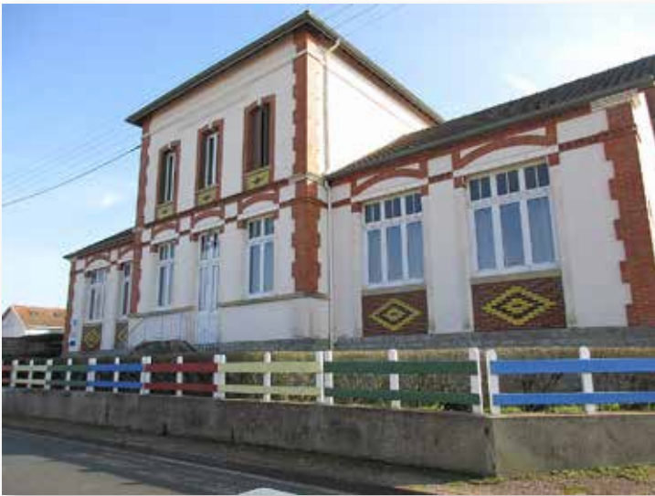
École maternelle du Champ du Moulin, 1903, architecte Jourdièr.
