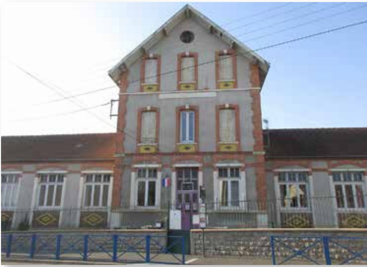
École maternelle Montceau-Bois du Verne (F. Pompon).
