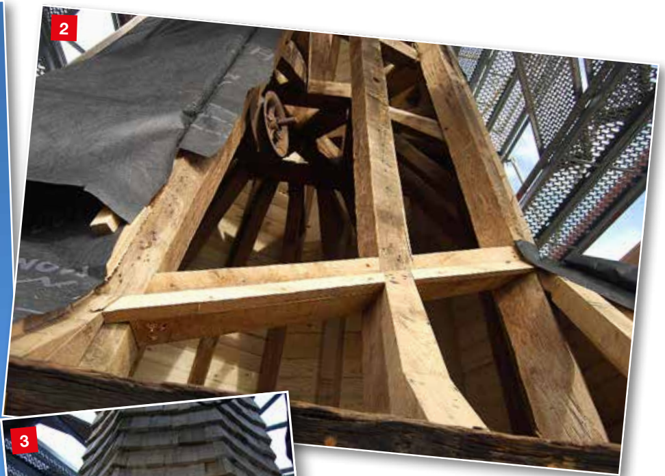
1. Le clocher restauré, le hourd et la flèche. 2 et 3 : Travaux de restauration de la flèche : la charpente, la couverture en essentes.
