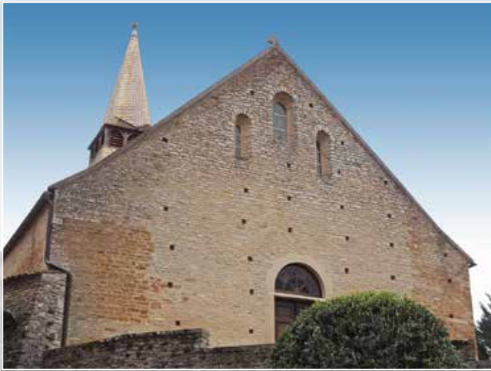
La façade ouest.
