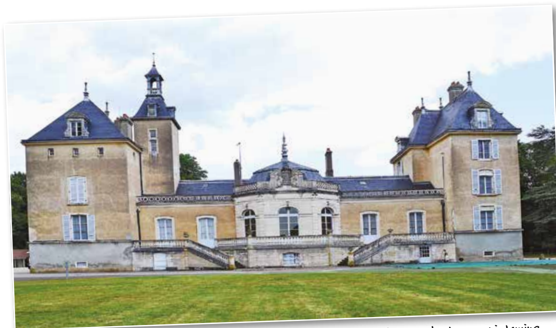
Fig.6 - La façade principale avec sur la gauche la tourelle carrée et sa lanterne qui domine l'ensemble (cette tour serait la partie la plus ancienne de l'édifice).
