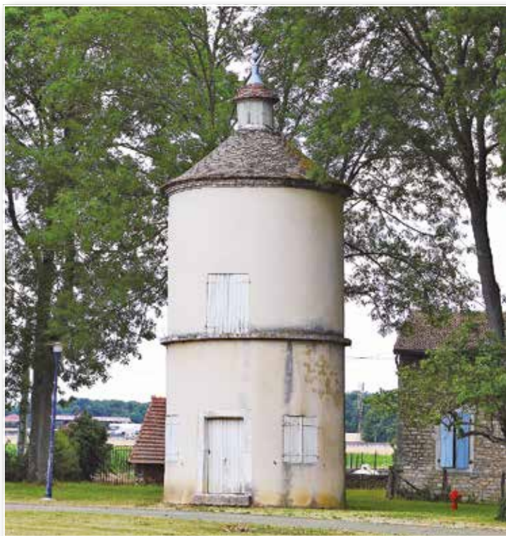
Fig.7 - L'ancien pigeonnier qui a été remanié.
