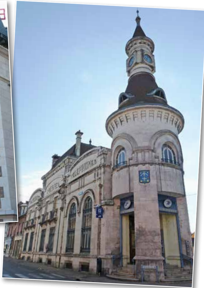
Poste de Digoin.
